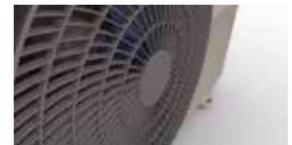
Luchtinlaat in de vorm van Archimedes-schroef
